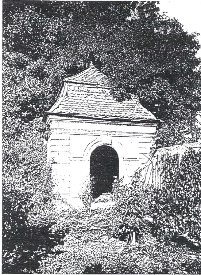
Mertinge. — Façade d'un des pavillons du jardin. (Cliché de M. L. Motiv.)
